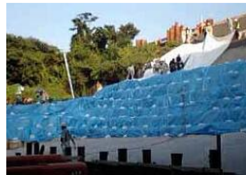
のり面シート養生 (8/15)
