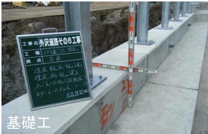
基礎工(EPS設置面)
