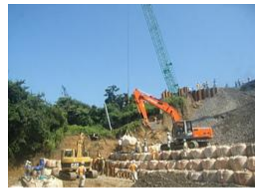
大型土のう617個 (8/13)
