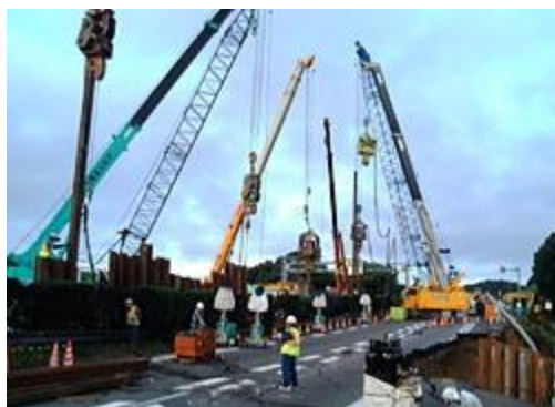
中央分離帯鋼矢板 (8/12)
