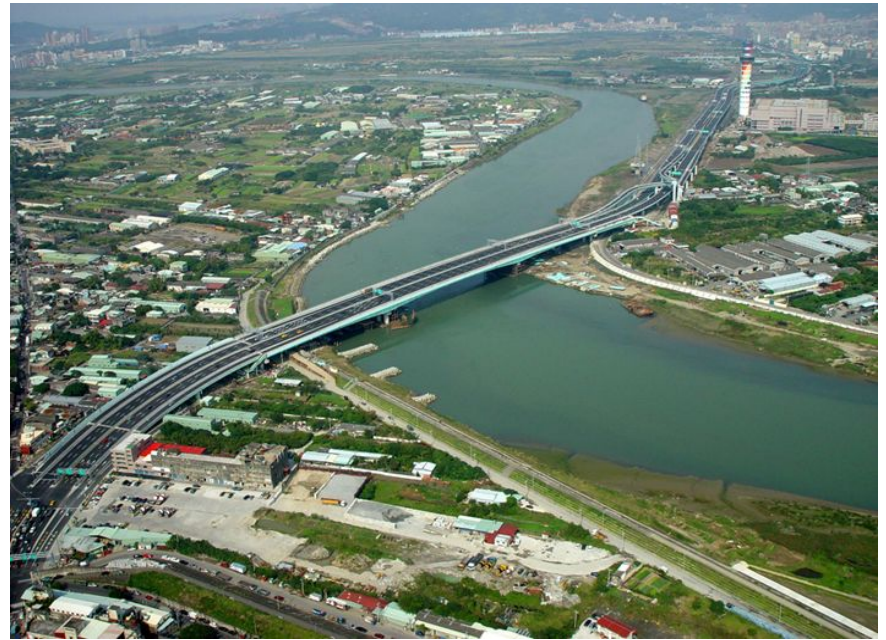
洲美快速道路堤防工程
