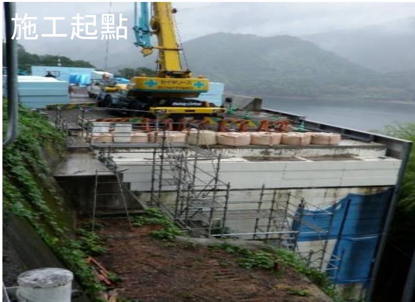
幹線部分EPS施工寫真
