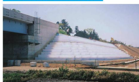
橋墩背面的填土施工工程
