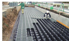
雨水貯留系統的施工工程
