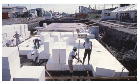
道路拓寬的施工工程
