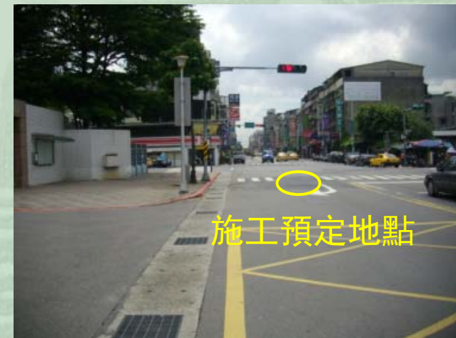
衛生下水道工程處的正門前
